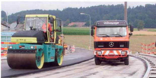
9: Die Walze AV 95 beim Verdichten der Spur A (links). 9: Le rouleau AV 95 compacte l'axe A (à gauche).
