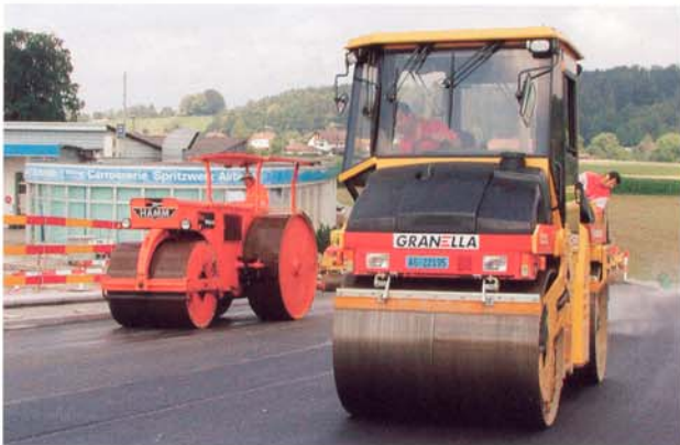
10: Die Walze CC 232 beim Verdichten der Spur B; links eine statische Walze beim Nachverdichten der Spur A. 10: Le rouleau CC 232 compacte l'axe B; à gauche, un rouleau statique effectue un compactage additionnel de l'axe A.
